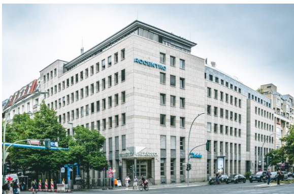
Berlin, Deutschland (Firmenzentrale)
